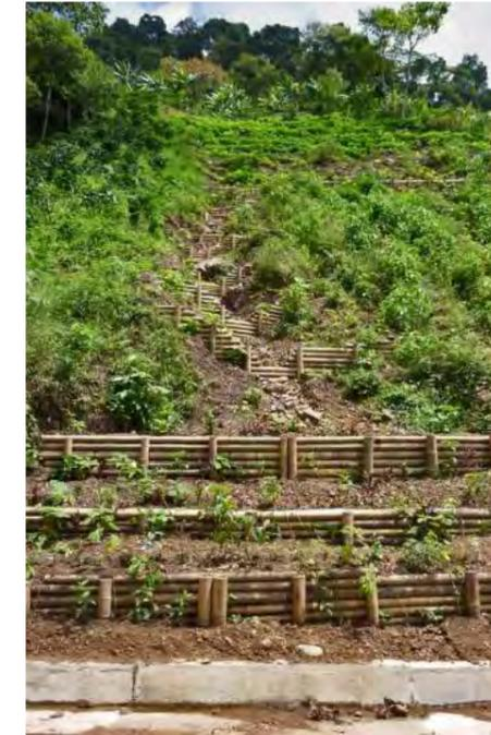
◀ Estabilización de talud con estructuras biomecánicas en guadua. Cuenca Río Amoyá, Tolima. Intervención inicial.
