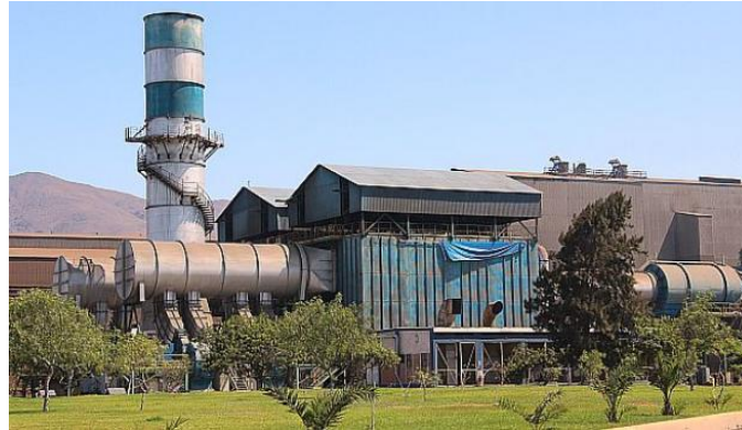
Foto 15. Horno Eléctrico con Un Capador de Emisiones – Chimbote
