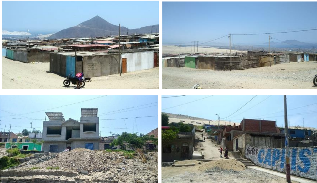
Foto 11. Viviendas con Alta Vulnerabilidad en el Sector Crítico de Riesgo 3
